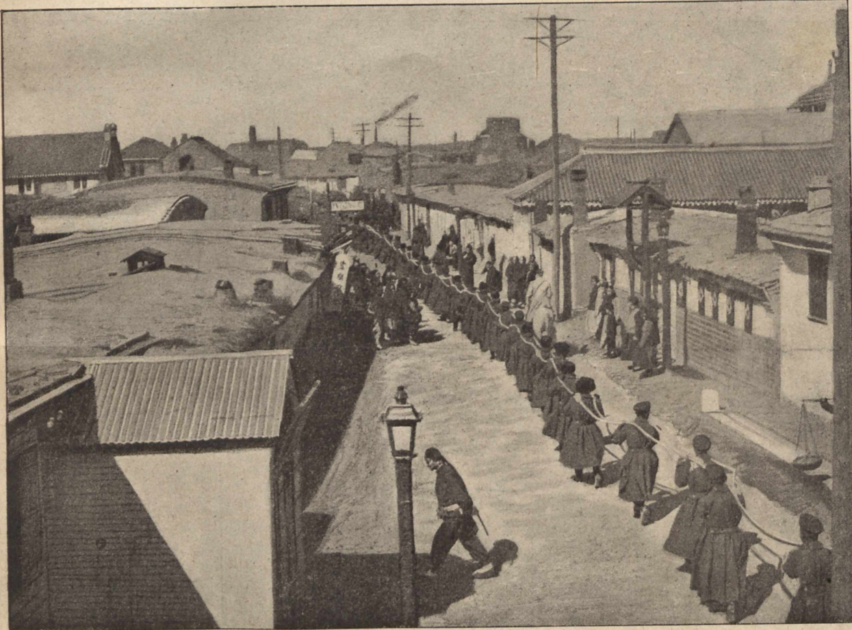
Transport przewodów do łączenia min podziemnych przez miasteczko Junszulin.
