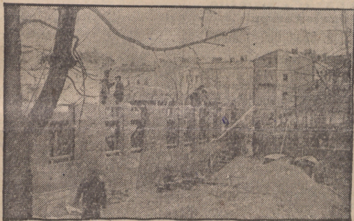
Tak wyglądały mury pawilonu lubelskiego „szybkościowca” — Kliniki Dermatologicznej UMCS po 7 godzinach pracy murarzy SPB.
