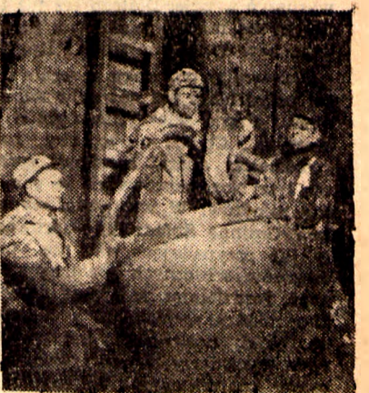
Roboty przy budowie warszawskiego metra postępują w szybkim tempie naprzód. W szeregu szybów śląscy górnicy prowadzą intensywną pracę przy drążeniu tzw. „korytarzy”, którymi w przyszłości przebiegać będą pociągi. Na zdjęciu: zakładowe haka do wielkiego kubła z „urobkami”. Od lewej górnik Antoni Haze, Jan Huśmienny i Eryk Dworaczek. (CAF — fot. Dzd. Wdowiński)
