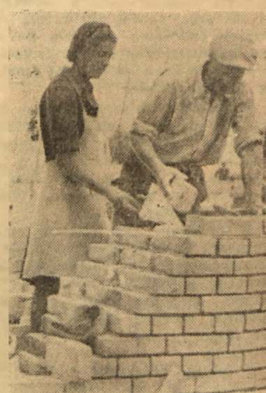
Sylwestra Swiergoń, pomoc murarska, produkuje w brygadzie Andrzeja Danieluka na budowie Kombinatu Tłuszczowego w Bodaczu.
