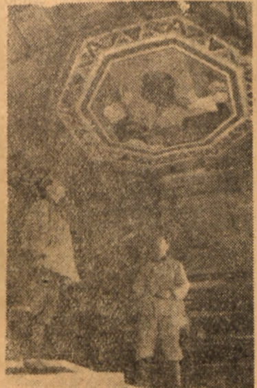
Na zdjęciu: fragment budowy metra moskiewskiego.
