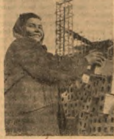
Szybko wznoszą się mury piekarni-giganta LSS. W pracy przy budowie kobiety nie ustępują mężczyznom.
