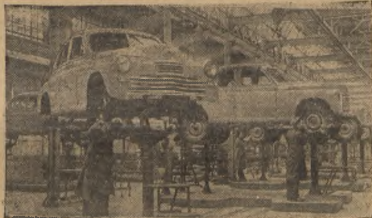
Montaż samochodów osobowych „Pobleda” systemem taśmowym w fabryce Im. Mołotowa.
