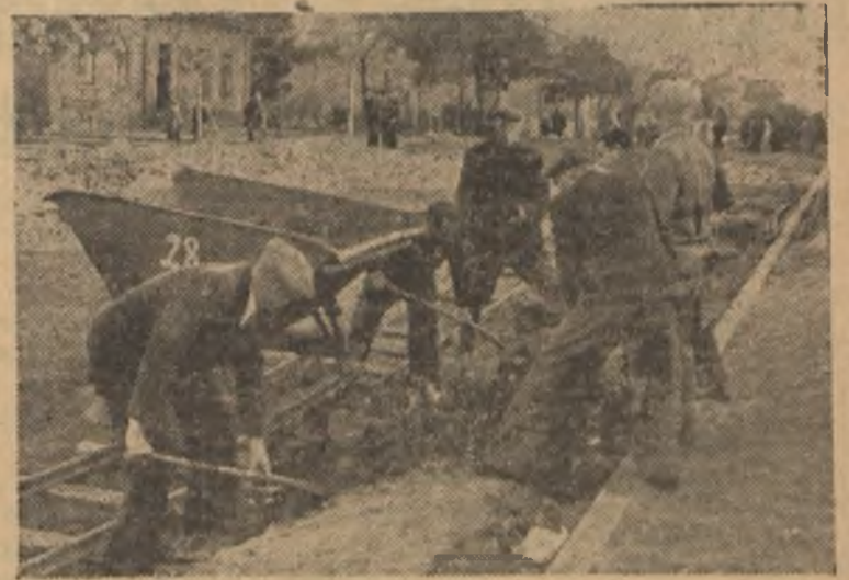
Pracownicy MKS przy przebudowie odcinka ul. Kunickiego w Lublinie, gdzie w przyszłym roku będą kursowały trolleybusy. (Foto Polński)
