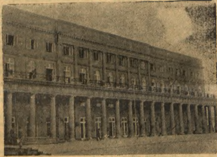
Teatr Narodowy w Warszawie odbudowany przez W. P. Już we wrześniu rozpocznie przedstawienia. Na zdjęciu fronton nowoodbudowanego budynku.
