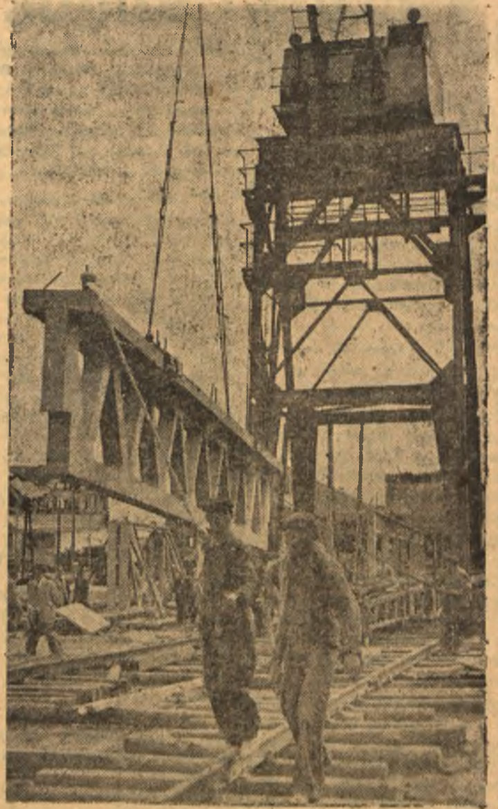
Wielki dźwig, który był na wystawie we Wrocławiu, pracuje przy zestawianiu elementów żelbetonowych hal fabrycznych Urzędzeń Radiowych w Warszawie. Na zdjęciu — przewożenie podciągu żelbetonowego 77-tonowego, na którym spoczywać będzie dach hal fabrycznej
