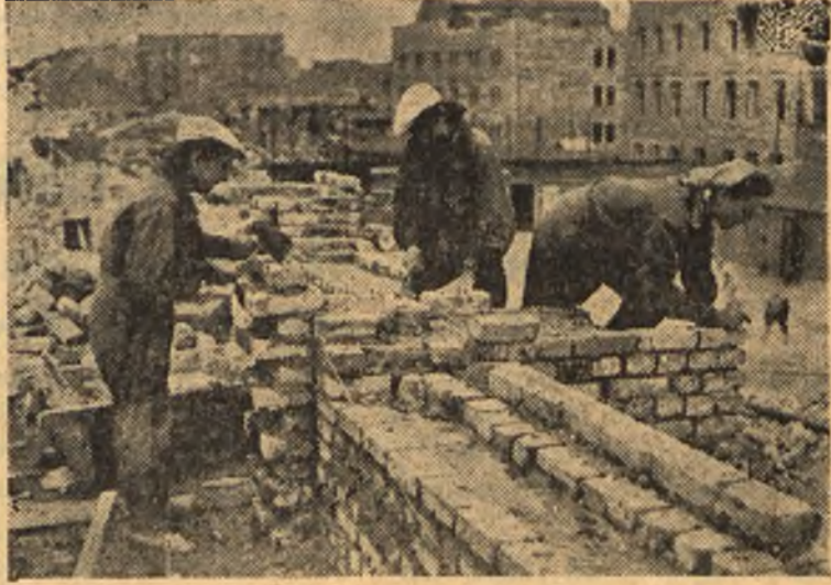
Na zdjęciu — Genowefa Michalik, Stanisława Kocielnicka i Kazimiera Malenda przy budowie osiedla robotniczego Z. O. R. na Mirowie w Warszawie. Foto — AR
