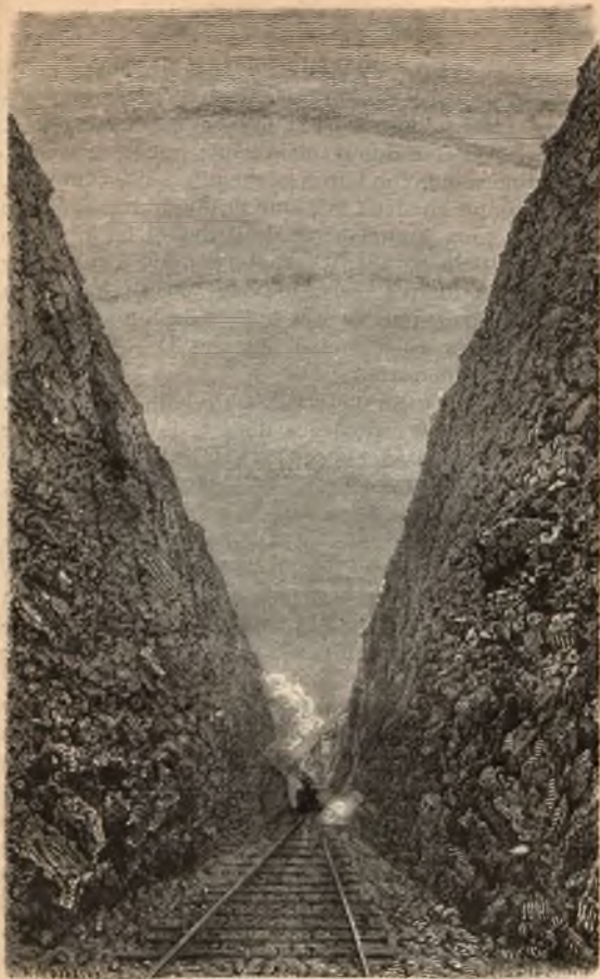
Fig. 74. — Une tranchée de chemin de fer.
