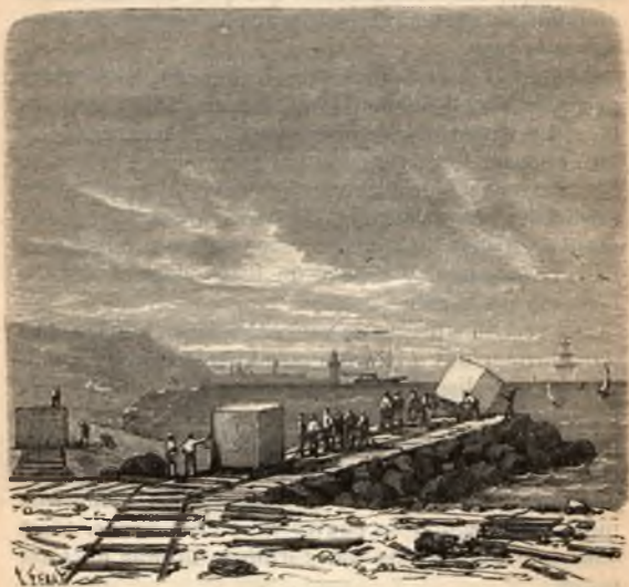
Fig. 73. — Construction d'une jetée en blocs artificiels.
