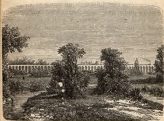
Fig. 75. — Pont-viaduc de l'Indre.
